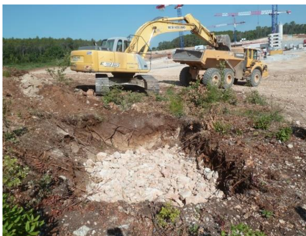
Mise en place de l'horizon 1 : matériaux grossiers avec un pouvoir drainant
