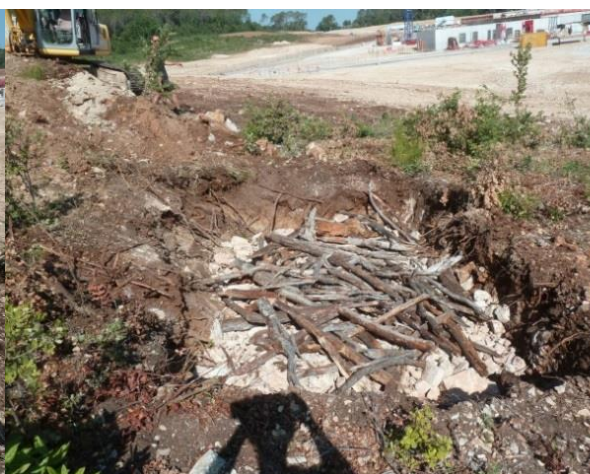
Mise en place de branches dans l'horizon 2
