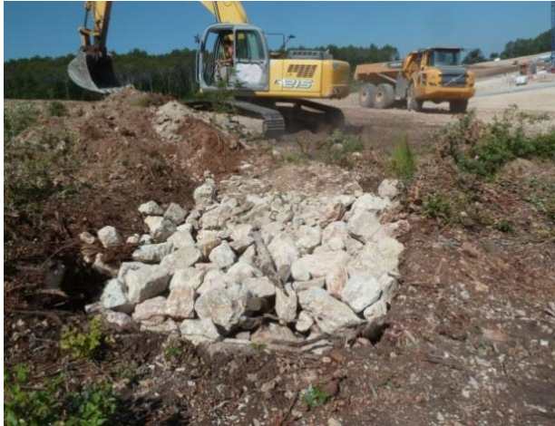
L'horizon 3 est composé de blocs de taille variée avec quelques gros blocs
